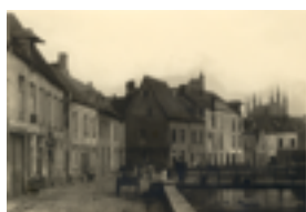
De Slachtstraat, samen met omliggende straatjes en percelen werden na 1914 helemaal afgebroken. De plannen waren al vastgelegd rond de eeuwwisseling, maar werden door de oorlogsverwoesting sneller tot uitvoering gebracht. (SAL, Fototheek)
